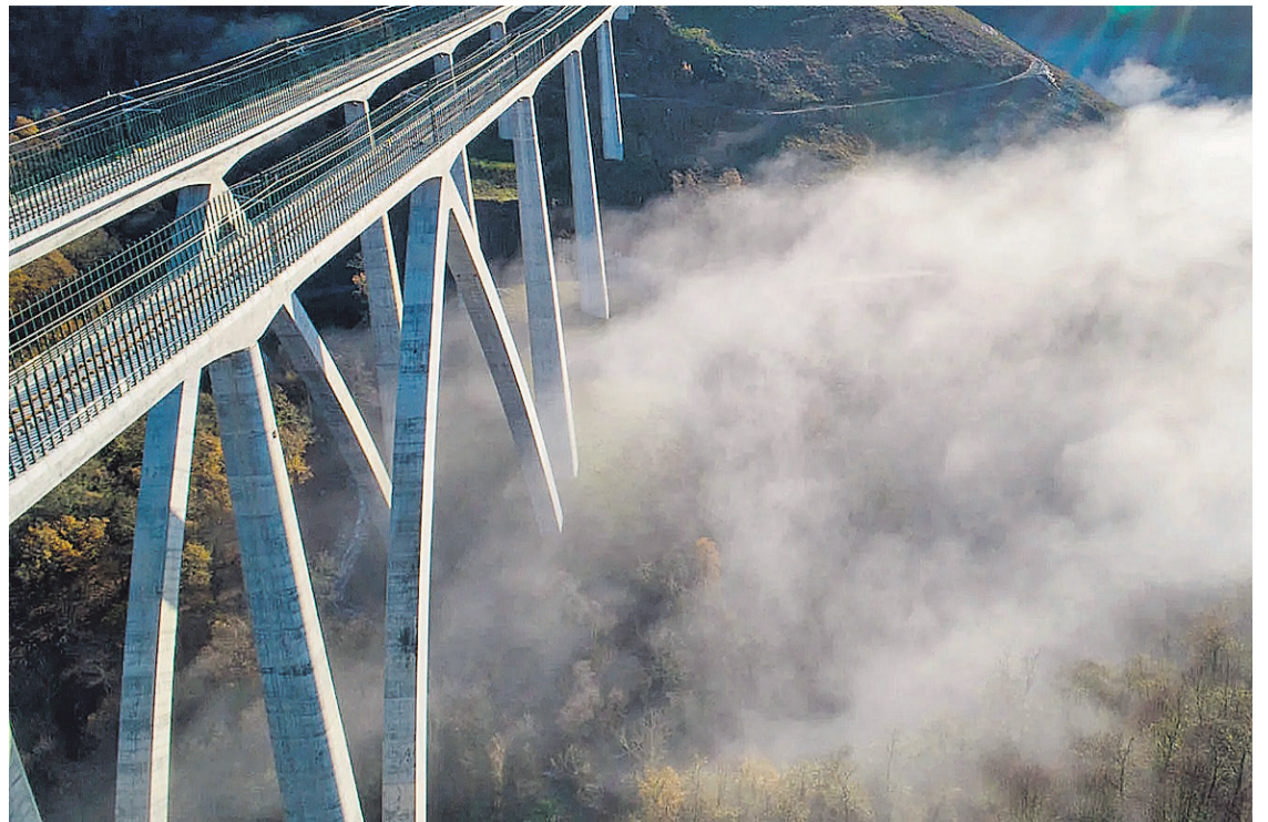
El viaducto de Teixeira, en el tramo de alta velocidad que se pondrá en servicio el 21 de diciembre. ADIF
